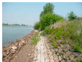
Ein mit Pflastersteinen gesicherter Uferabschnitt
