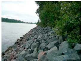
Aktueller Zustand: Ein mit Wasserbausteinen gesicherter Uferabschnitt
