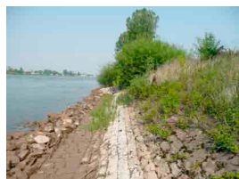
Ein mit Pflastersteinen gesicherter Uferabschnitt
