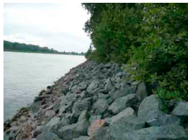
Aktueller Zustand: Ein mit Wasserbausteinen gesicherter Uferabschnitt
